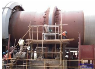
RECTIFICATION : de bandages et de galets sur tubes tournants
